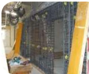
③鉄筋の周りに型枠を作り型枠の内部にコンクリートを流し込む。
